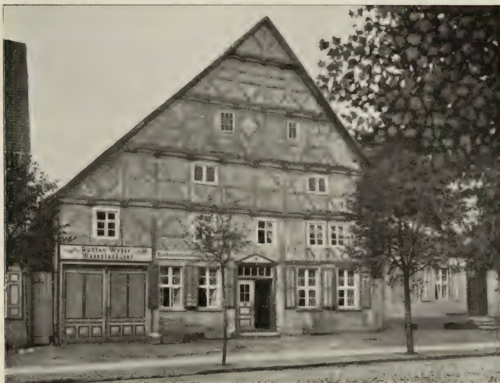
Fig. 172. Kyritz. Fachwerkhaus Wilhelmstr. 51.
